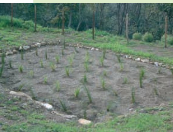
Impianto di fitodepurazione a flusso sommerso orizzontale da 60 mq, piantumato con scirpus (piante in crescita).
