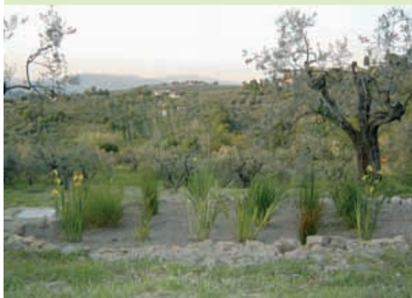
Impianto di fitodepurazione a flusso sommerso orizzontale da 15 mq, piantumato con juncus e iris.
